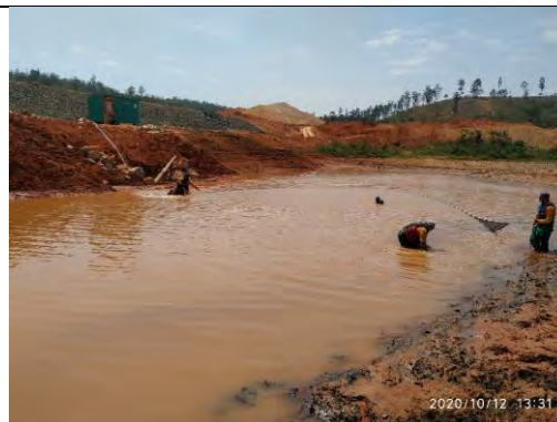
Lagoa formada a jusante da ensecadeira
