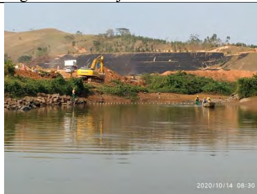
Lagoa maior formada a jusante da ensecadeira
