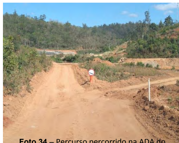
Foto 34 – Percurso percorrido na ADA do empreendimento. (Data: 16/10/2020)
