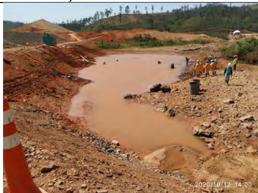
Lagoa formada a jusante da ensecadeira
