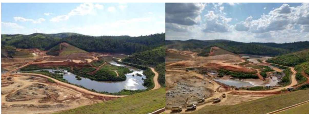
Fotos 4.1-11 e 4.1-12. Vista das obras de desvio do rio Jaguari.
