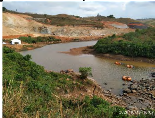
Lagoa formada a jusante da ensecadeira
